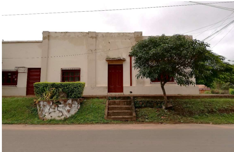
Fachada de la edificación sobre la calle Mcal. López. Se distinguen las dos etapas constructivas por el tratamiento diferente de las fachadas: altura y morfología.
