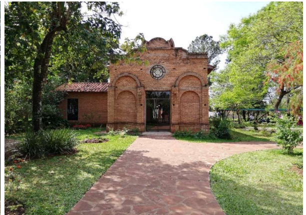
Capilla San Vicente ubicada en el predio del asilo de ancianos con acceso desde la calle Iturbe.
