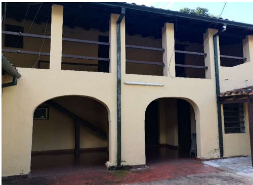
Fachada posterior de la edificación: galerías posteriores en planta baja y alta con pilares de mampostería.
