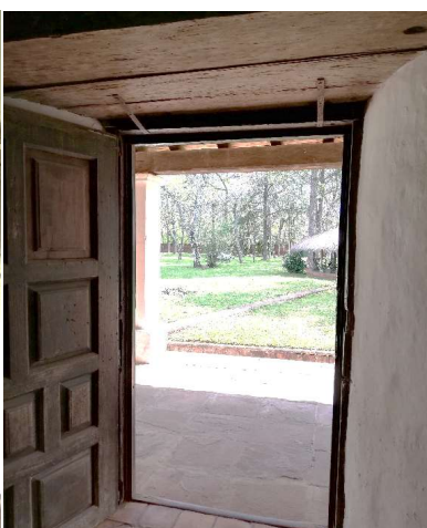
Aberturas de madera de la época de la Reducción.
