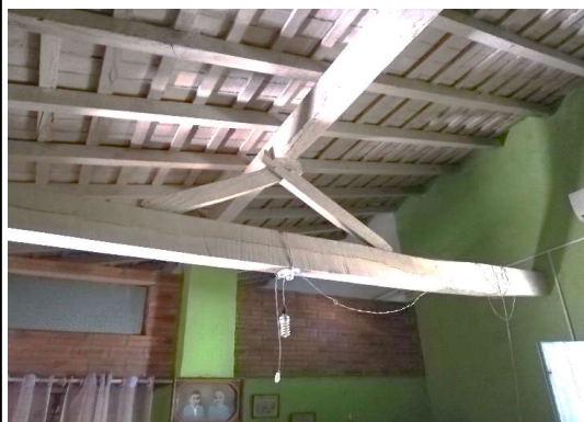
Interior del volumen de acceso, donde se observa una cabriada de madera que sostiene la cubierta.
