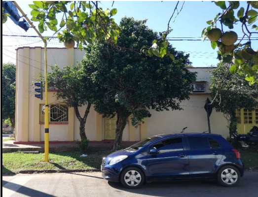
En la fachada sobre la calle Mariscal López se aprecia la unión entre los bloques, contando el más nuevo con una altura menor.
