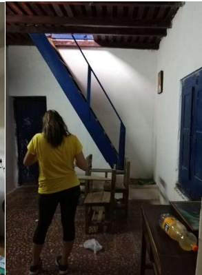
Sector de entrepiso de madera. Al fondo, se aprecia también, la escalera de madera que conduce a la planta alta.
