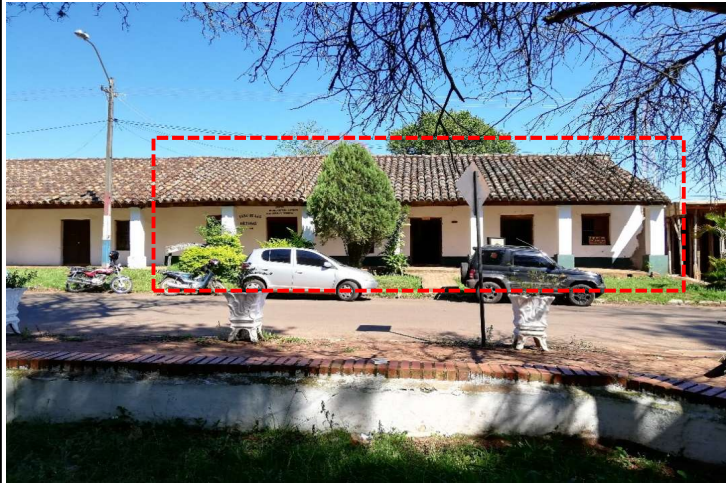
Vista de la tira de viviendas de indios, de izquierda a derecha el Museo, la CODENI y el registro.
