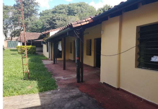
Vista del bloque posterior en planta baja. Constituye la segunda etapa de construcción. Posee una galería con pilares de madera que permite la conexión entre los espacios componentes del segundo bloque; distribución "en chorizo". En el fondo se aprecia la tercera etapa de construcción.
