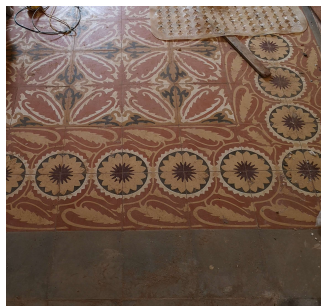
Pisos calcáreos originales de la vivienda.
