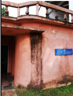
Acceso a la fundación. Este posee un voladizo de hormigón.
