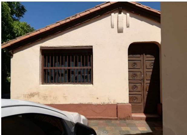
Fachada del bloque de servicio: es posible acceder al mismo tanto, desde el interior de la vivienda, como de forma directa desde la calle.
