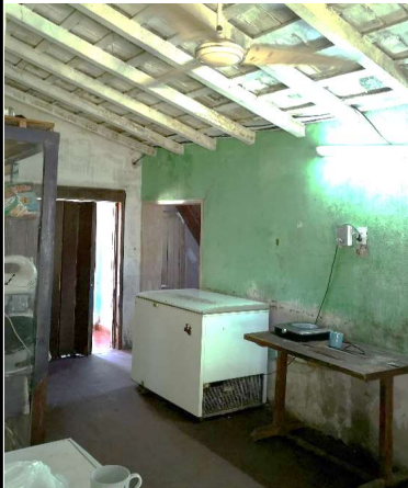
Sector de cocina/comedor, posterior a la edificación original.
