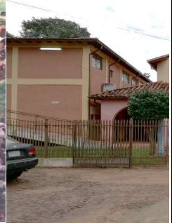
Edificación contigua al edificio patrimonial, la cual sobrepasa la rasante establecida por este último.
