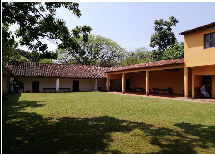
Vista del conjunto desde el patio. Se observa a la galería como espacio de vinculación entre ambas edificaciones.
