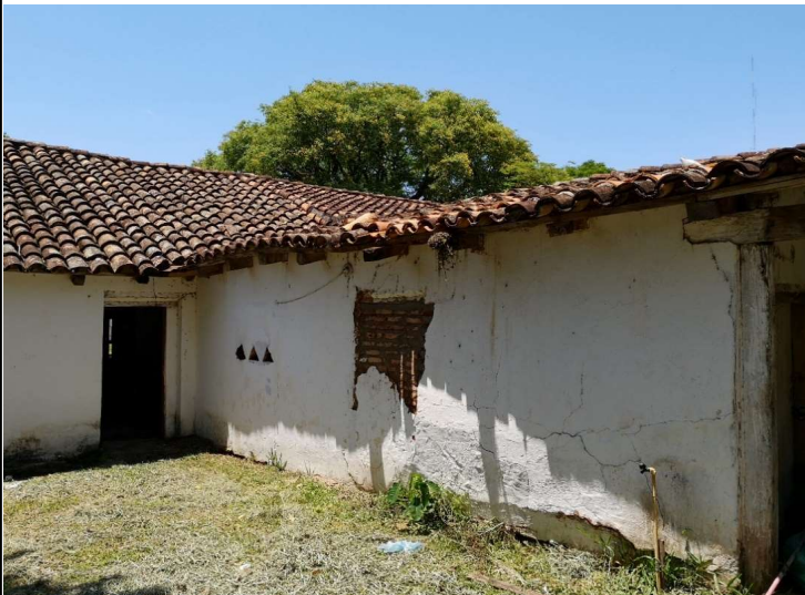
Edificación posteriormente añadida a la construcción original en la década del 60' aproximadamente. Esta se encuentra contigua a la antigua vivienda de indios y se encuentra en un avanzado estado de deterioro.
