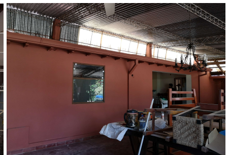
Quincho comedor edificado posteriormente. En la parte superior se observa la unión entre las cubiertas de tejas cerámicas y metálica.
