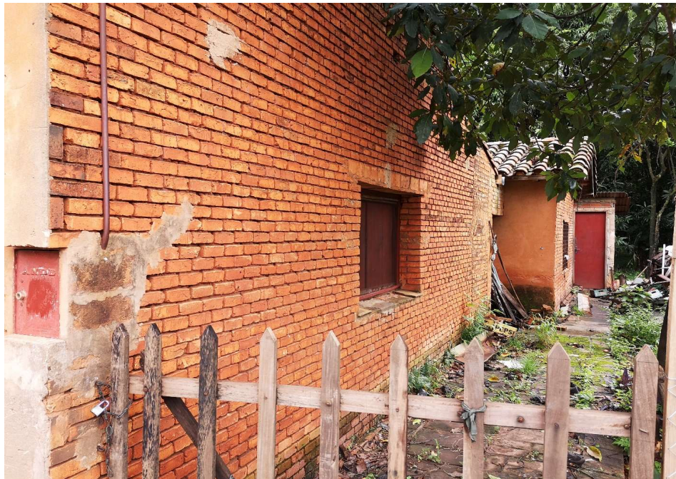
Las diferentes etapas constructivas del inmueble se manifiestan en volúmenes independientes y con diversas caídas de techos.
