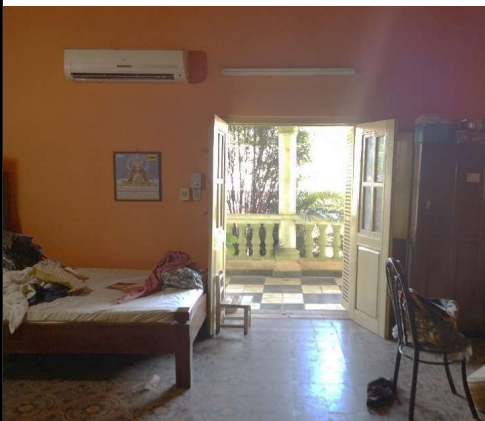
Los dormitorios ventilan a la galería frontal únicamente a través de las puertas.
