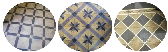
Diseños geométricos en los solados: en cada habitación del inmueble se encuentran diseños diferentes.
