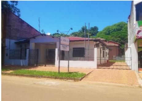
Fachada sobre la calle Julio L. Pérez: en el frente se observa bloque nuevo terminado en el año 2019, y en el fondo la edificación patrimonial.
