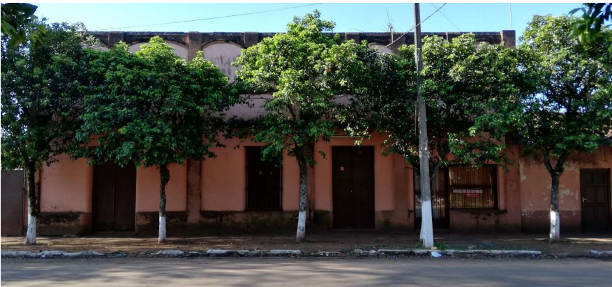
Fotografía tomada en año 2018 del bloque correspondiente a la segunda etapa de construcción. Se presume que el mismo fue construido entre las décadas del 40' y 70', mientras que el bloque con galerías a principios del s XX.
