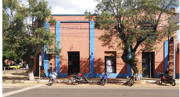
Vista de la edificación desde la Ruta N°1 Mcal. Francisco Solano López, actual Restaurante Donel.
