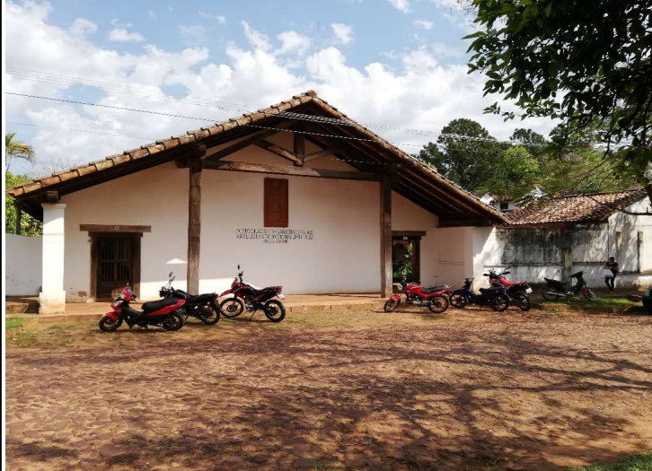
Fachada del Museo, donde se aprecia el volúmen posterior añadido, correspondiente al área administrativa y a la casa de retiros.
