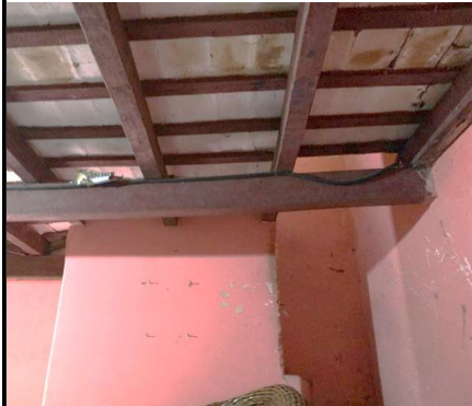
Imagen del interior del depósito, donde se observa el espacio destinado a la escalera, y el sistema constructivo de la época.
