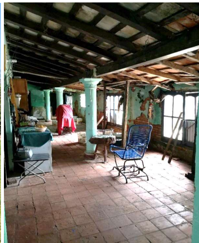
Edificación posterior construida en la década del 80' aproximadamente.
