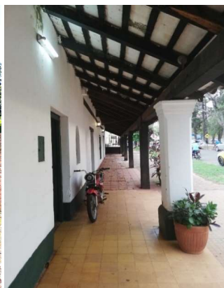
Fotografía tomada desde la galería frontal del museo. Se aprecia la estructura del techo: tejas y tejuelitas cerámicas sobre alfajas, tirantes y vigas de madera.
