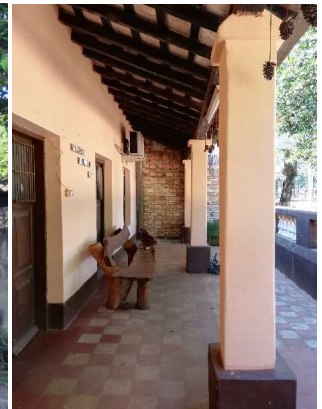
Vista desde la galería del bloque más antiguo.
