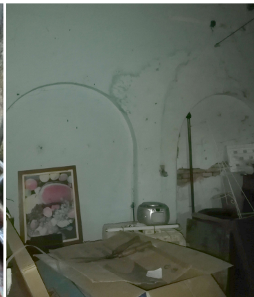
En la fotografía se aprecian los arcos que unían el interior de la vivienda con la galería.
