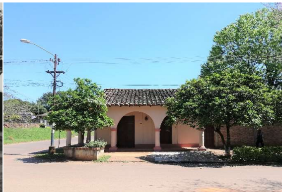
Fachada actual de la vivienda sobre la calle Cerro Corá.
