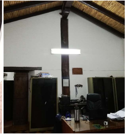
Pilar embebido en muro que evidencia la estructura maderera de las viviendas de la época de las reducciones.
