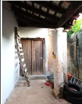
Galería interior: se observa el techo de tejuelitas y tejas cerámicas sobre tirantes y vigas de madera, y pilar de mampostería en "L".
