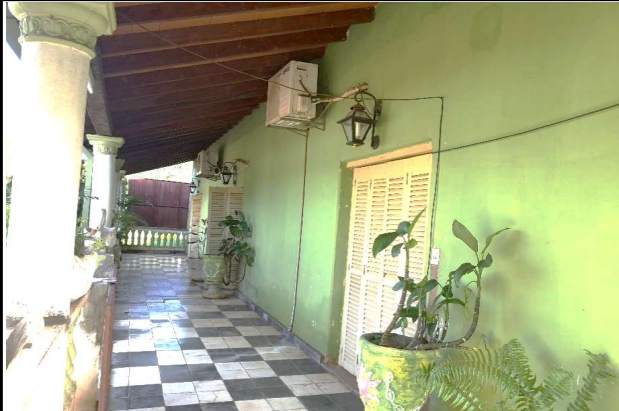
Vista de la galería frontal de la vivienda.
