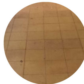
Solado cerámico presente en toda la edificación.
