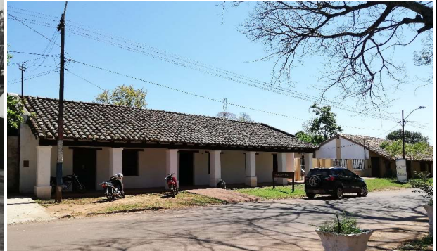
Vista de la Casa del Ganadero desde la calle Cerro Corá.
