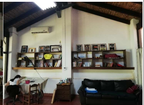
Se aprecian tres de los seis pilares agregados para el sostenimiento del techo.
