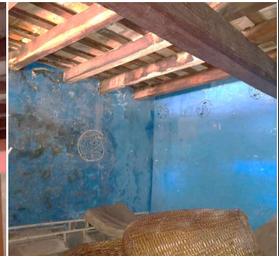
Bloque de la esquina, donde funcionaba anteriormente el gimnasio.
