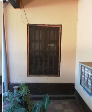
Muro de retranqueo correspondiente al segundo bloque.
