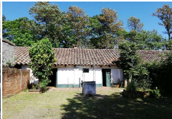
Vista posterior de la edificación: se observa la galería interior cerrada por las construcciones agregadas (sanitario, depósito y extensión de la sala de exposiciones); y el aljibe.
