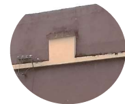
Vestigios de pilastras en la fachada.
