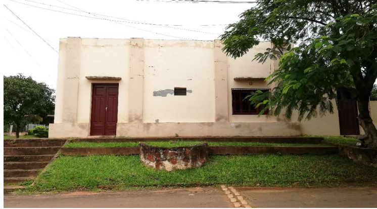
Fachada de la edificación sobre la calle Padre Marcial de Lorenzana. Se observa la modificación de la abertura intermedia y el portón de acceso al patio de la vivienda.
