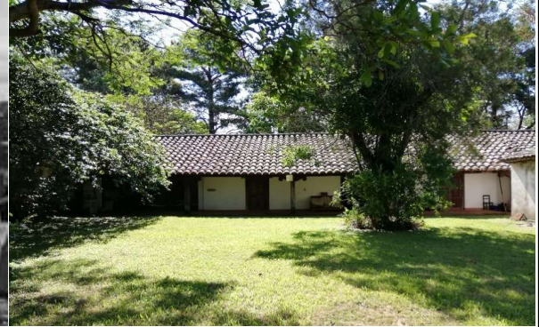
Vista de la edificación desde el patio posterior.
