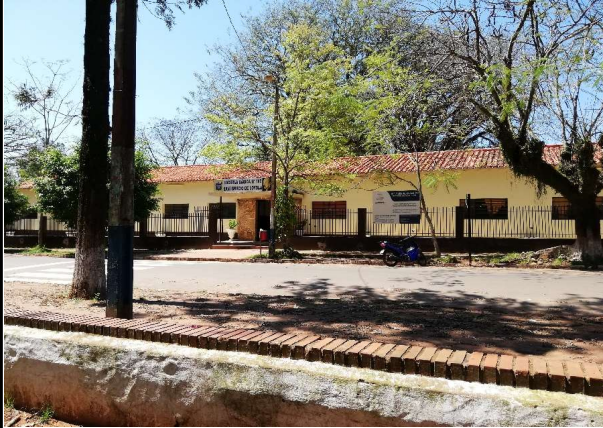
Volumen correspondiente a la tercera etapa de construcción, ubicado sobre la calle Iturbe.
