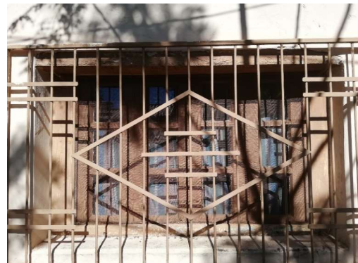
Detalle de las ventanas de la fachada frontal.
