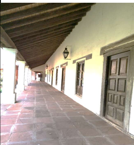
Vista de la galería lateral de acceso, donde se observan los pisos de piedra y una de las caídas del techo con dirección al patio central.
