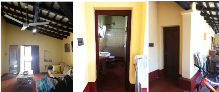
Vistas interiores de la vivienda. Se observa el techo original de tejuelititas sobre alfájas, tirantes y vigas de madera, y el techo de chapa en la galería agregada en la unión entre los bloques, así como también, el sanitario original.
