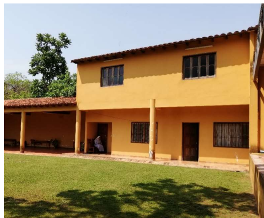
Volumen posterior añadido al volumen original, que cuenta con estructura de hormigón armado.
