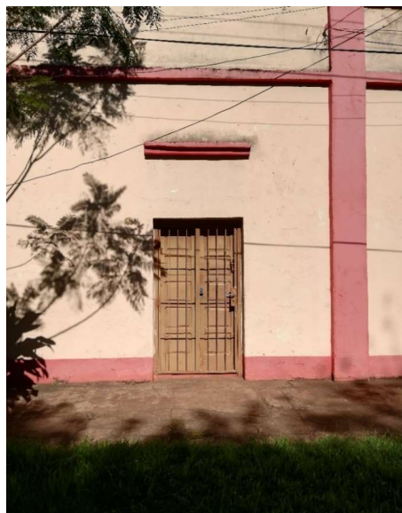
Detalle del acceso a la vivienda.
