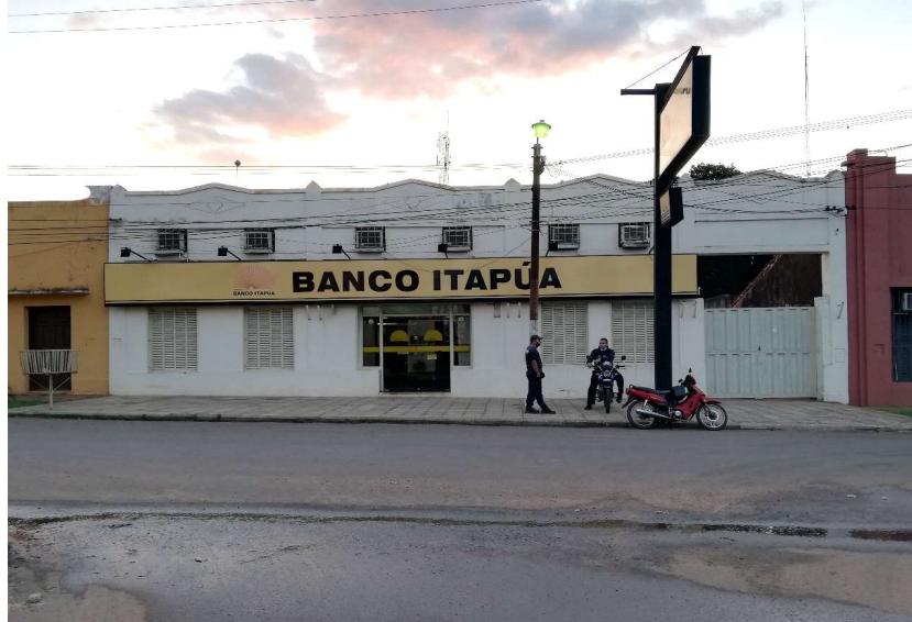
Foto tomada el 20 de septiembre del año 2018 cuando la edificación funcionaba como Banco Itapúa.
