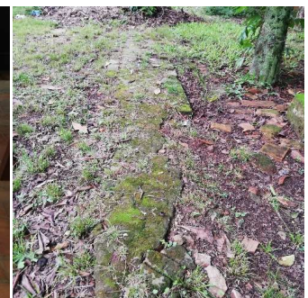
Cimentación de la antigua edificación correspondiente al colegio o casa de padres de la reducción.
