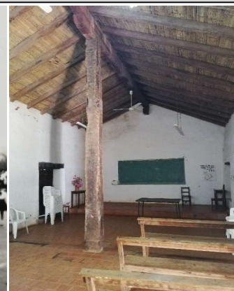
Vista interior de la antigua capilla del colegio San Luis, actual sala de reuniones. Se observa el pilar de madera en el centro del salón, el cual se presume se encontraba embebido en el muro que dividía este espacio en dos lances.
