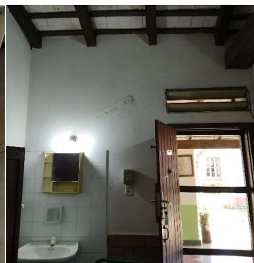
Interior de una de las habitaciones tipo.
