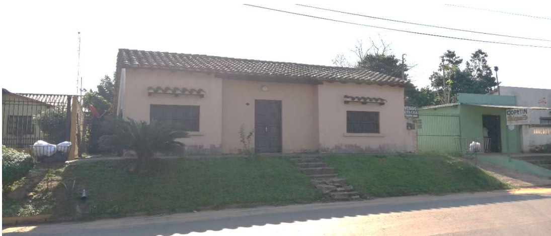
Vista exterior de la vivienda, donde se observa la caída del techo a dos aguas.
