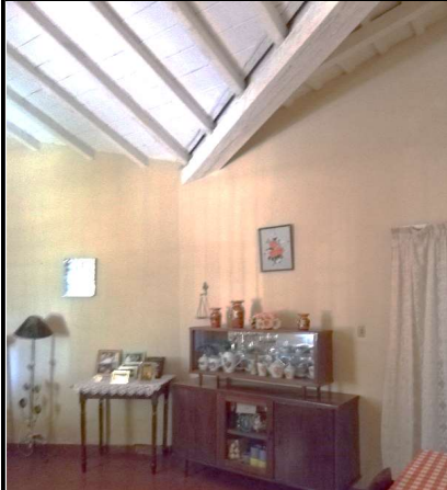
Estar situado en la esquina de la vivienda, donde se observa a la viga lima hoyo y el techo de tirantes y tablonés de madera.
