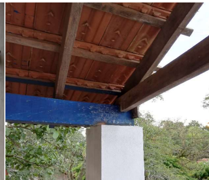
Techo en planta alta: vigas, firantes, alfajas y tejas francesas.
