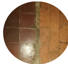
Solados presentes en la edificación: área social y área de servicio, respectivamente
