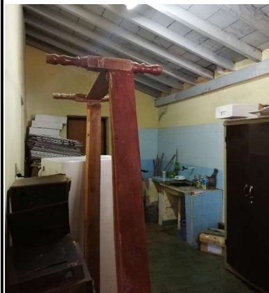
Espacio conexo a la recepción de la edificación, que funciona actualmente como depósito.
