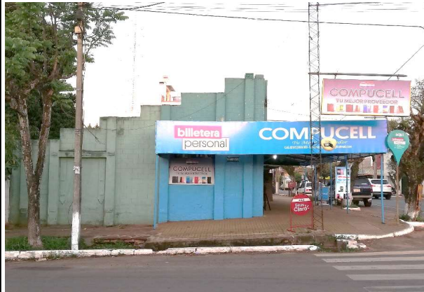
Fachada lateral de la edificación sobre la calle Fulgencio Yegros, con escalonamiento en el coronamiento del muro, detalle característico del art decó.
