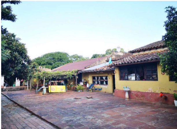
Patio trasero de la edificación. Se observan las caídas de los techos.
