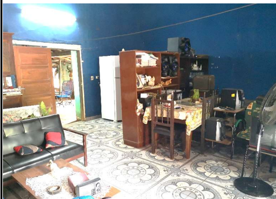
Interior de la edificación patrimonial. A la derecha se observa la abertura de conexión con la edificación posterior.
