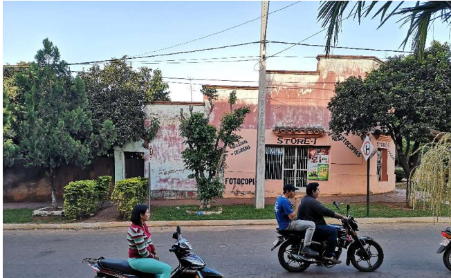
Vista de la edificación desde la calle Mcal. López.
