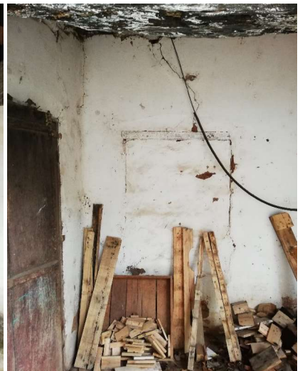
Abertura cerrada que comunicaba el interior de la vivienda con el depósito semicubierto.
