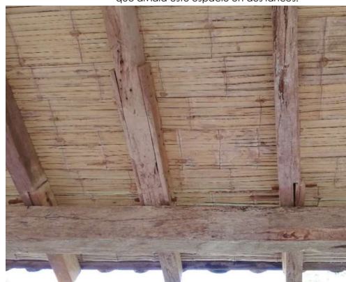
Vista de la cubierta de tirantes, vigas de madera y tacuarillas, recientemente restaurada.
