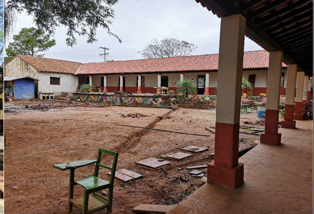
Los trabajos de restauración, iniciados en diciembre del 2018, se llevan a cabo en los tres bloques del colegio, así como en el patio central. Estos trabajos incluyen el cambio de techo, piso, muros, mejoramiento de las instalaciones eléctricas y pluviales, entre otros.
