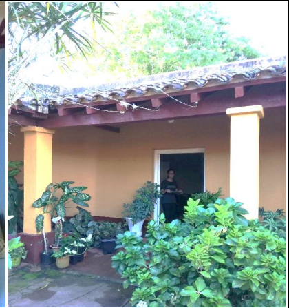
Encuentro de techos en el volumen de la esquina, comunicado al patio por medio de las galerías.
