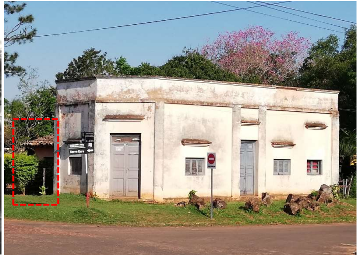
Foto del 2018 de la edificación situada en la esquina. Al fondo se observa el volumen correspondiente al bloque de servicios.
