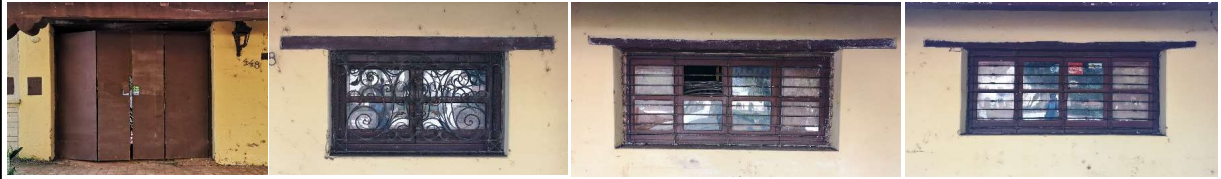
Detalles de aberturas. La primera, corresponde al acceso vehicular situado a la derecha. Se presume que todas las aberturas pertenecen a una etapa posterior de intervención.
