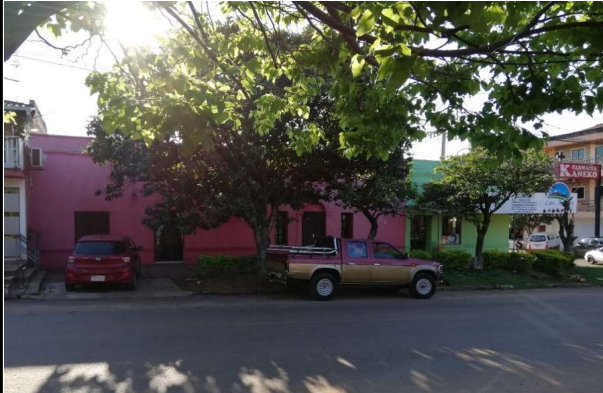
Fachada de la edificación sobre la calle Mariscal López. Se presume que en el volumen color rosa se da la función residencial, mientras que en el de esquina, la comercial.
