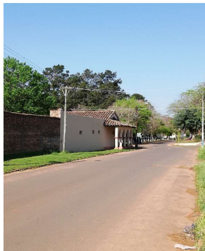
Vista del edificio desde la calle Marcial de Lorenzana.
