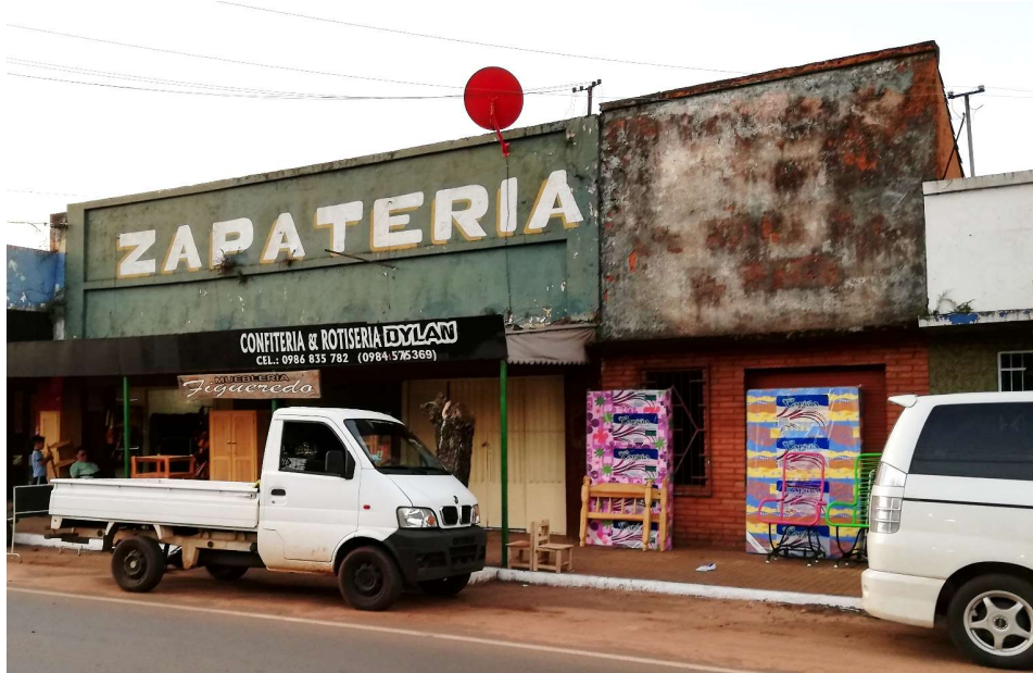
Fotografía tomada desde la Ruta N°1. Se observa que la fachada del bloque comercial tiene la misma altura que el edificio contiguo, mientras que con el bloque habitacional comparte la misma rasante del alero.
