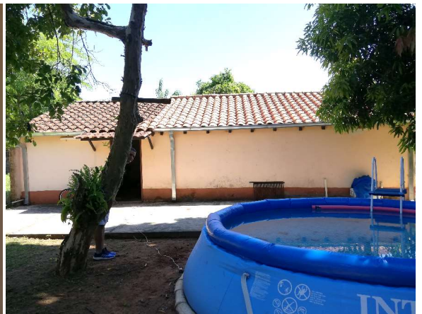
Vista posterior de la vivienda. En la fotografía se observa a la izquierda la nueva construcción unida al bloque de servicio.
