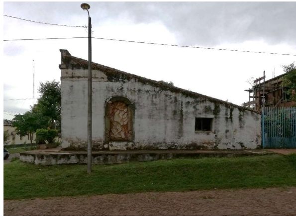
Vista de lateral de la vivienda desde la calle Iturbe. A la derecha el edificio habitacional de dos niveles.
