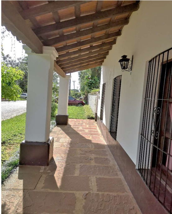
Vista de la galería exterior de la vivienda, donde se observan los pisos posteriores y el techo original, conformado por vigas, tirantes, alfajías y tejuelitas.
