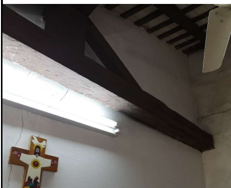
Interior de una de las habitaciones, donde se observa una cabriada, posiblemente utilizada como estructura del antiguo salón auditorio, posteriormente este fue dividido por medio de un muro.
