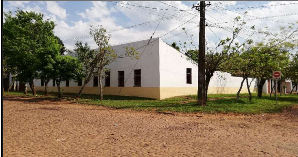
Vista a la edificación antigua desde la esquina de las calles Iturbe y Capitán del Puerto.
