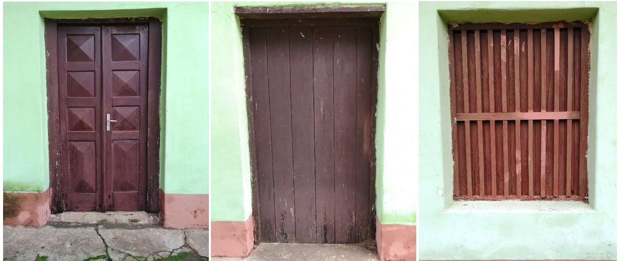
Detalles de las aberturas. La primera fotografía corresponde a la puerta del acceso principal, y la segunda a la del acceso secundario. Se observa la diferencia de nivel de detalles en el tratamiento de ambas puertas: la principal posee terminación más fina con detalles geométricos. Todas las ventanas del edificio son iguales a la que se observa en la tercera fotografía: de dos hojas y con rejas de madera.
