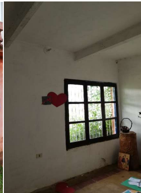
Sala donde se observa la losa con estructura de vigas de madera y ladrillos, y con terminación revocada.
