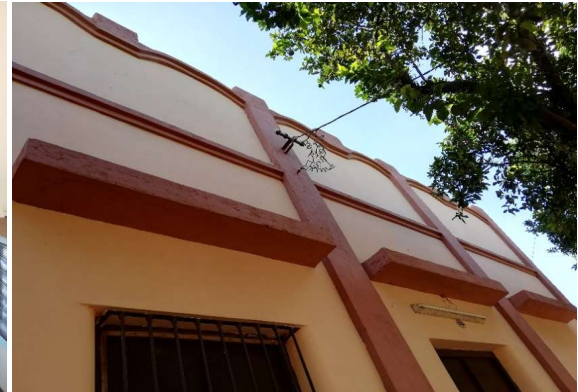
Detalles y ornamentos en la fachada implantada sobre línea municipal.
