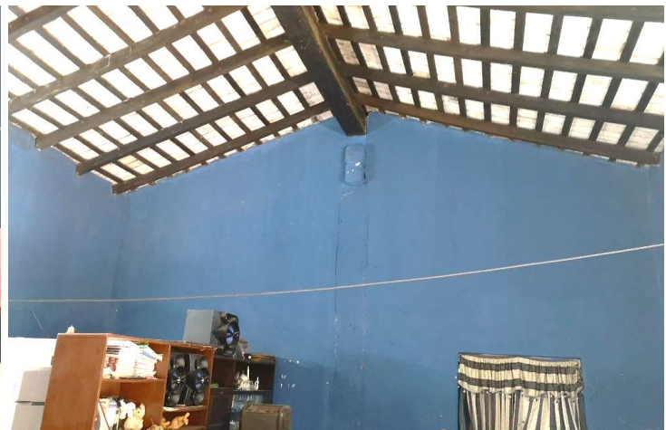
Techo a dos aguas ya modificado. En la imagen se aprecia el pilar embebido en el muro, al igual que en las demás edificaciones de la época de la reducción.
