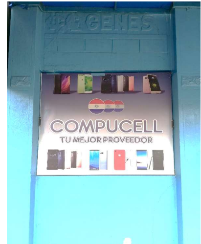
Inscripción con el apellido "Genes" en el muro de la fachada principal.
