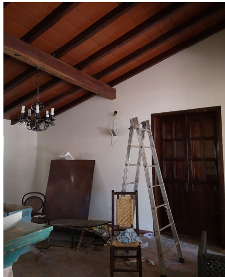
Comedor de la vivienda, en ese entonces en proceso de restauración (junio-2019), con el techo ya modificado.
