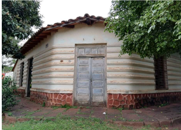
Vista del acceso en ochava al ex-almacén de ramos generales, actualmente se encuentra desocupado. Se observa el detalle de la caída del techo en la esquina.
