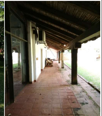
Galería interior. Se observa la utilización de este espacio como expansión del estar social interior.
