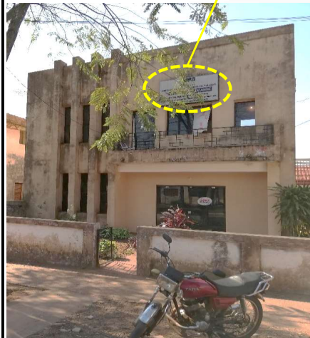
Fachada principal donde se observa la cartelería de la DINACOPA.
