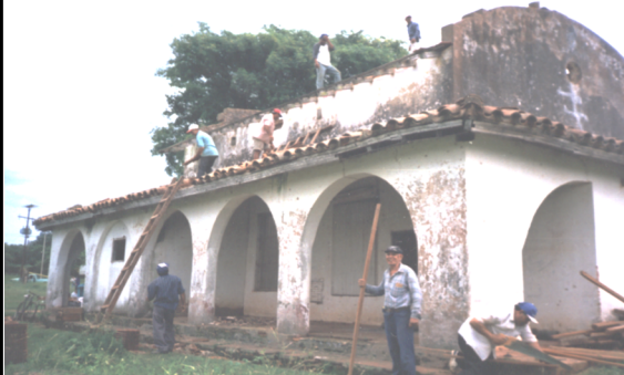
Restauración de la edificación patrimonial correspondiente al antiguo Mercado Guazú que funcionó hasta la década del 40' aproximadamente.
