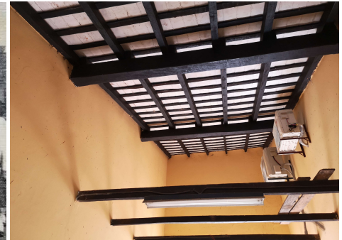
Imagen en la que se observa la estructura de vigas, tirantes y fejuelitas de la cubierta. En la fotografía se observa además, el probable soporte de un cielorraso.
