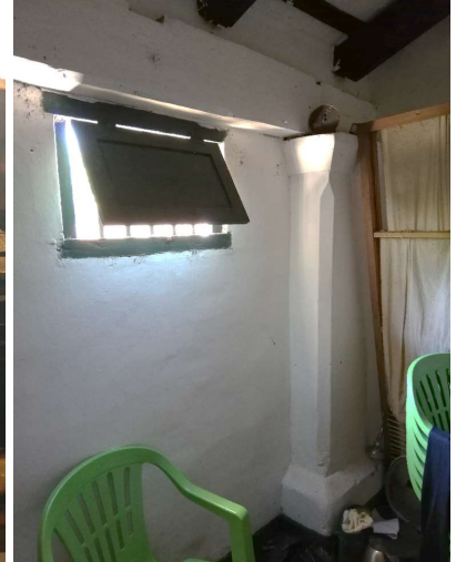
Imagen del interior del depósito. Se observa el pilar perteneciente a la galería posterior del edificio.
