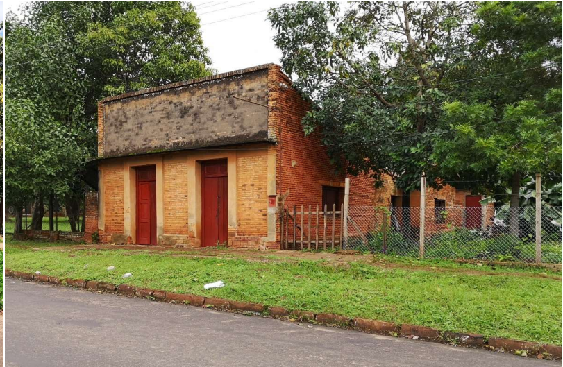
Conjunto total de la edificación: predominancia del material cerámico.
