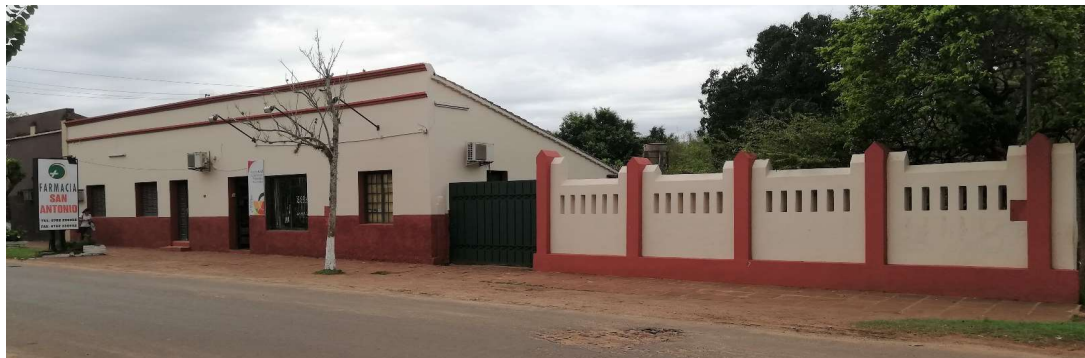
Vista total del conjunto.
