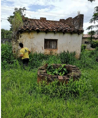
Vista posterior de la edificación.
