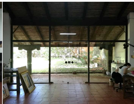
Interior del cuarto lance. Se observa la supresión de los muros originales y la inserción de los pilares de mampostería, así como también, los paños de vidrio que cumplen la función de cerramiento vertical.
