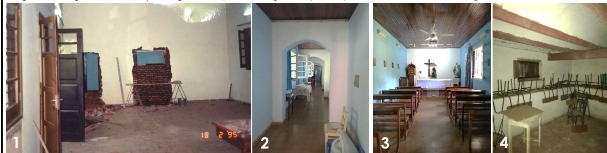
Imágenes del interior del primer bloque. 1 y 2- En 1995 se realizaron por segunda vez refacciones en el bloque original, para la adaptación de las antiguas aulas en habitaciones con baños privados para las hermanas. 3- Vista interior de la capilla ubicada sobre la calle Iturbe. 4- Sótano agregado en la remodelación del año 1959, actualmente funciona como depósito. El entrepiso es de bovedilla de ladrillos sobre tirantes y vigas de madera.
