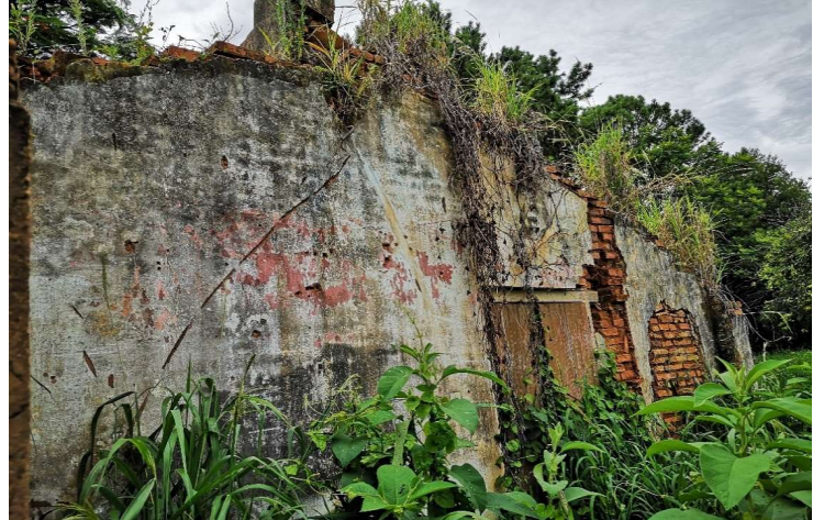
Vista desde el sector demolido, se aprecian los vestigios de los muros demolidos.
