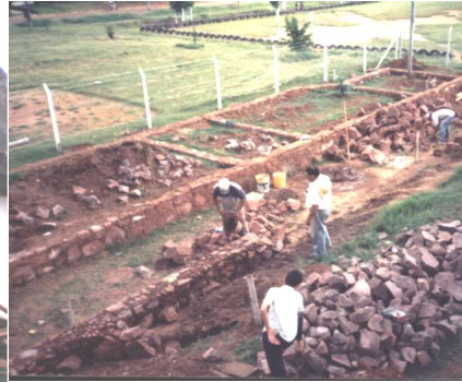
Construcción del primer bloque agregado al inmueble patrimonial.
