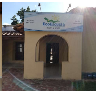
Fachada sobre la calle Cerro Corá: ingreso a la edificación a través del "porche" de acceso.
