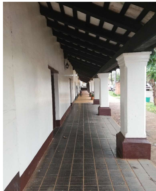
Vista de la galería frontal de la edificación. Se aprecia la calidad urbana de la "calle cubierta" conformada por las galerías del tirón de viviendas de indios. El techo del inmueble está conformado por tejas y tejuelitas cerámicas sobre alfajas, tirantes y vigas de madera.
