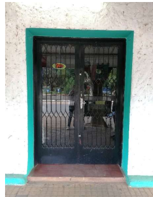
Como se puede apreciar en la imagen, varias aberturas originales fueron sustituidas.
