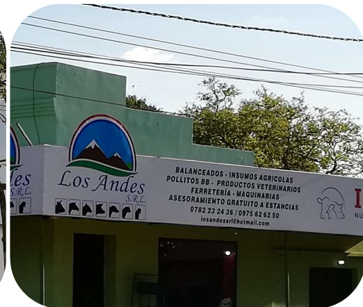
Detalle del escalonamiento en el coronamiento de la fachada sobre la calle Félix Bogado.
