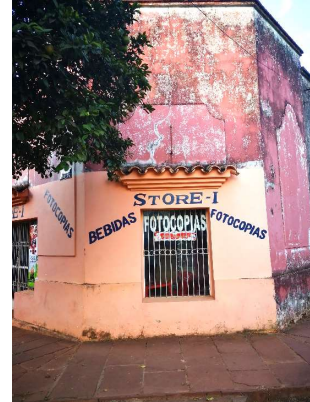
Vista de la esquina, donde se aprecia el detalle de tejas sobre la abertura.
