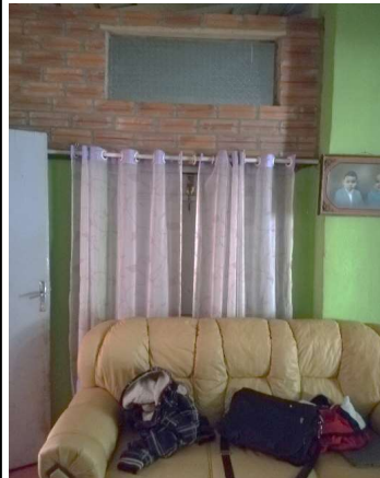
Muro divisorio, añadido en el sector de la sala, con el fin de independizar lo que fuera un gran salón y generar un nuevo ambiente: un salón comercial en alquiler.
