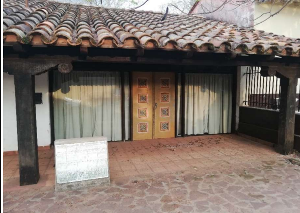
Vista de la fachada frontal del cuarto lance: debido a su materialidad la morfología del conjunto se ve alterada.
