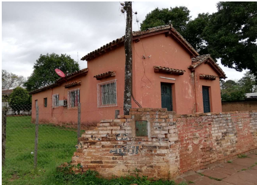
En la imagen se observan las diferentes alturas de los techos, así como también las etapas de construcción, que probablemente fueron dos, dando paso a un crecimiento en "chorizo".
