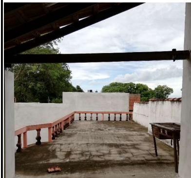
Vista del segundo nivel del inmueble, donde se observa a la losa superior de ladrillos con carpeta, y las barandas de balaustres.
