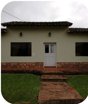
Acceso principal a la vivienda.
