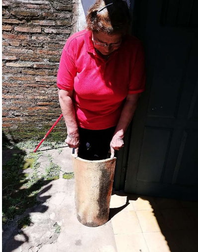
Teja original de la edificación; se aprecian las grandes dimensiones de la misma (60cm de largo x 30cm de ancho).
