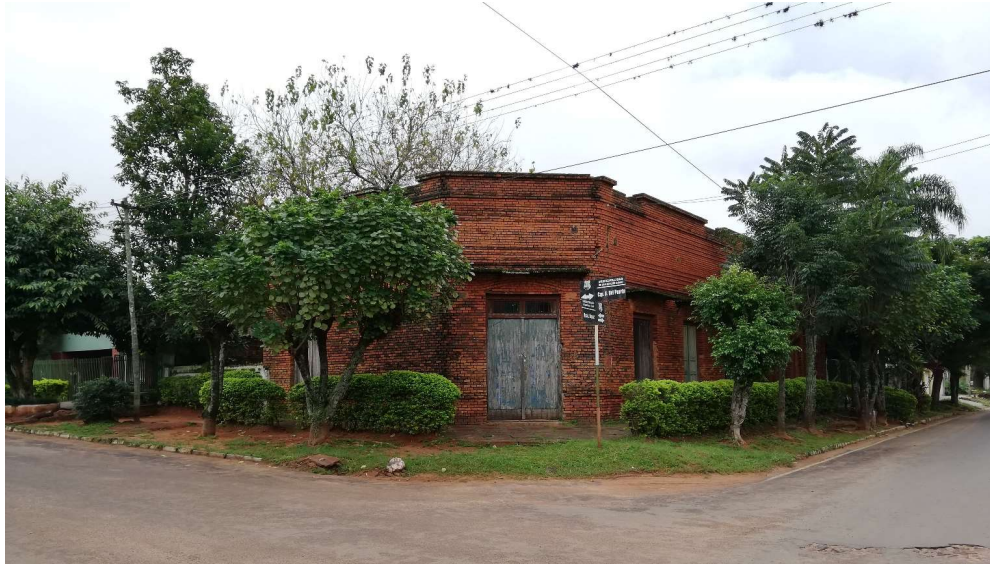
La edificación es el único ejemplo de la tendencia estilística "arts and crafts" en el centro histórico de la ciudad (existen otros en el área urbana). En su fachada se puede apreciar el trabajo manual del constructor.
