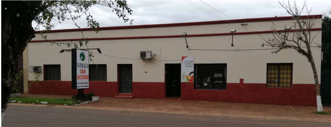
Fachada sobre la calle San Roque González de Santacruz. Ésta cuenta con tendencia estilística modernista de fachada tapa y una longitud total de 20,80 mts.
