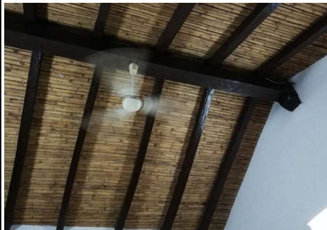
Techos de tejas y tacuarillas, que descansan sobre una estructuras de tirantes, vigas y pilares de madera.
