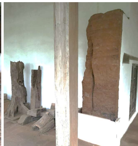
Muro de adobe, testigo de la materialidad de los muros, situado en la fachada posterior del Museo.
