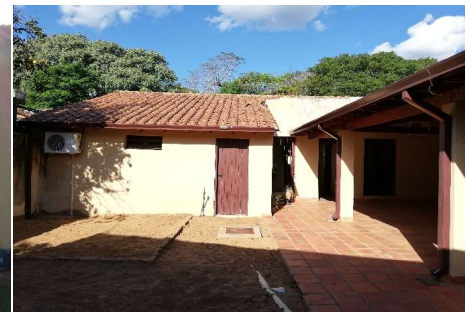
En la imagen se aprecia el volumen de la edificación posterior con una distribución lineal y galerías en conexión con el patio interior.
