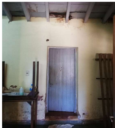
Abertura de conexión entre la edificación antigua y la nueva.
