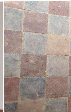
Pisos originales restaurados recientemente.
