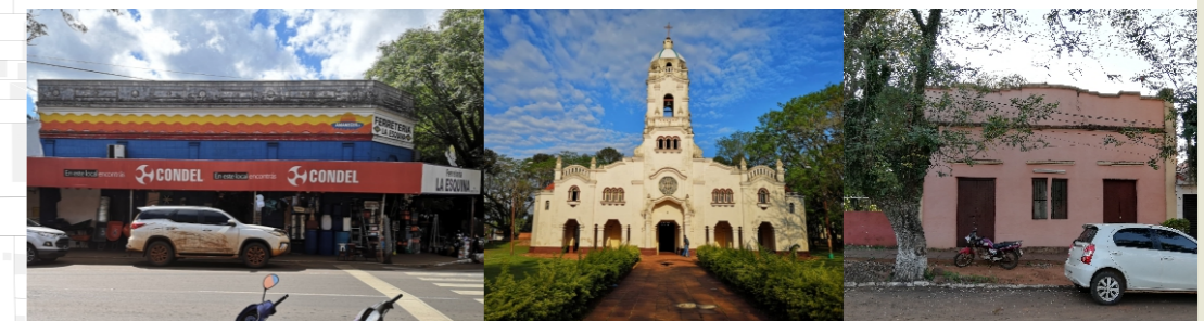
Ferretería "La Esquina" de valor arquitectónico.
