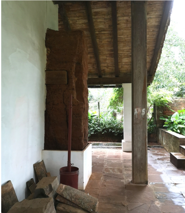
Muro de tapial, testigo del sistema constructivo del Museo Diocesano de Arte Jesuítico - Guaraní.
