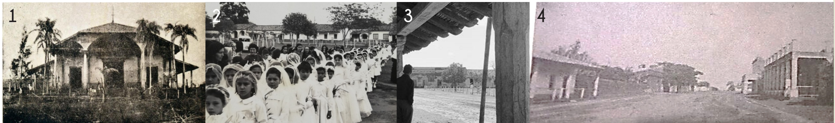
1- Iglesia San Ignacio de Loyola proyectada por Tomás Mármol a principios del siglo XVIII y derribada en 1920. 2- Fotografía tomada en el año 1965 en la que se observa los lances del tirón de viviendas de indios oeste: entre la Vivienda Pino y la Ecoescuela tres lances en ruinas, hoy desaparecidos. 3- Fotografía tomada desde el tirón de viviendas de indios oeste, en el fondo se observan viviendas de tendencia estilística neoclásica (al sur de la Plaza de la Iglesia). 4- Fotografía tomada en el año 1928 en la Ruta N°1 Mcal. Francisco Solano López. Se observan viviendas con galería frontal e implantadas sobre la línea municipal. De éstas, solo persiste el Sanatorio ImaGill (margen derecho).
