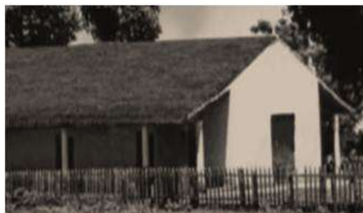
Capilla de Caaguazú, construida en estaqueo, techo de paja y galerías laterales (1852)
