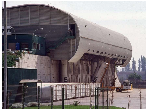
DESCARGA DIRECTA A 12 SILOS VERTICALES.
