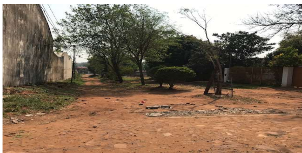
Calle sin nombre en mal estado.
