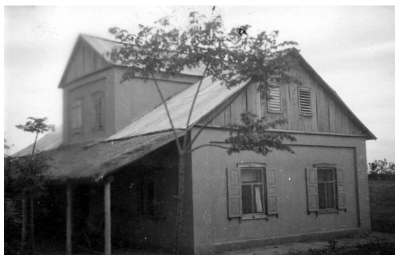
Cuadro 81: Vivienda del año 1955. Fuente: Archivo de la Colonia Fernheim
