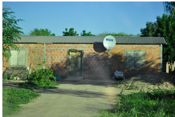
Cuadro 41. Vivienda multifamiliar. Fuente: N. Wall, 2018
