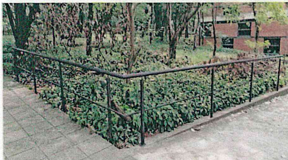
Figura 75 Barandas metálicas
