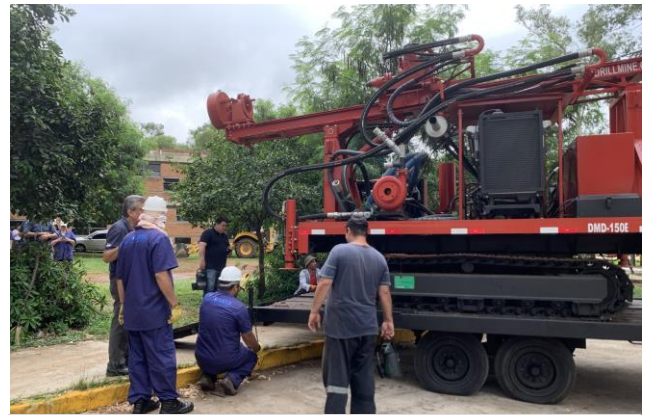
Fig. 159 Máquinas para el pozo artesiano
