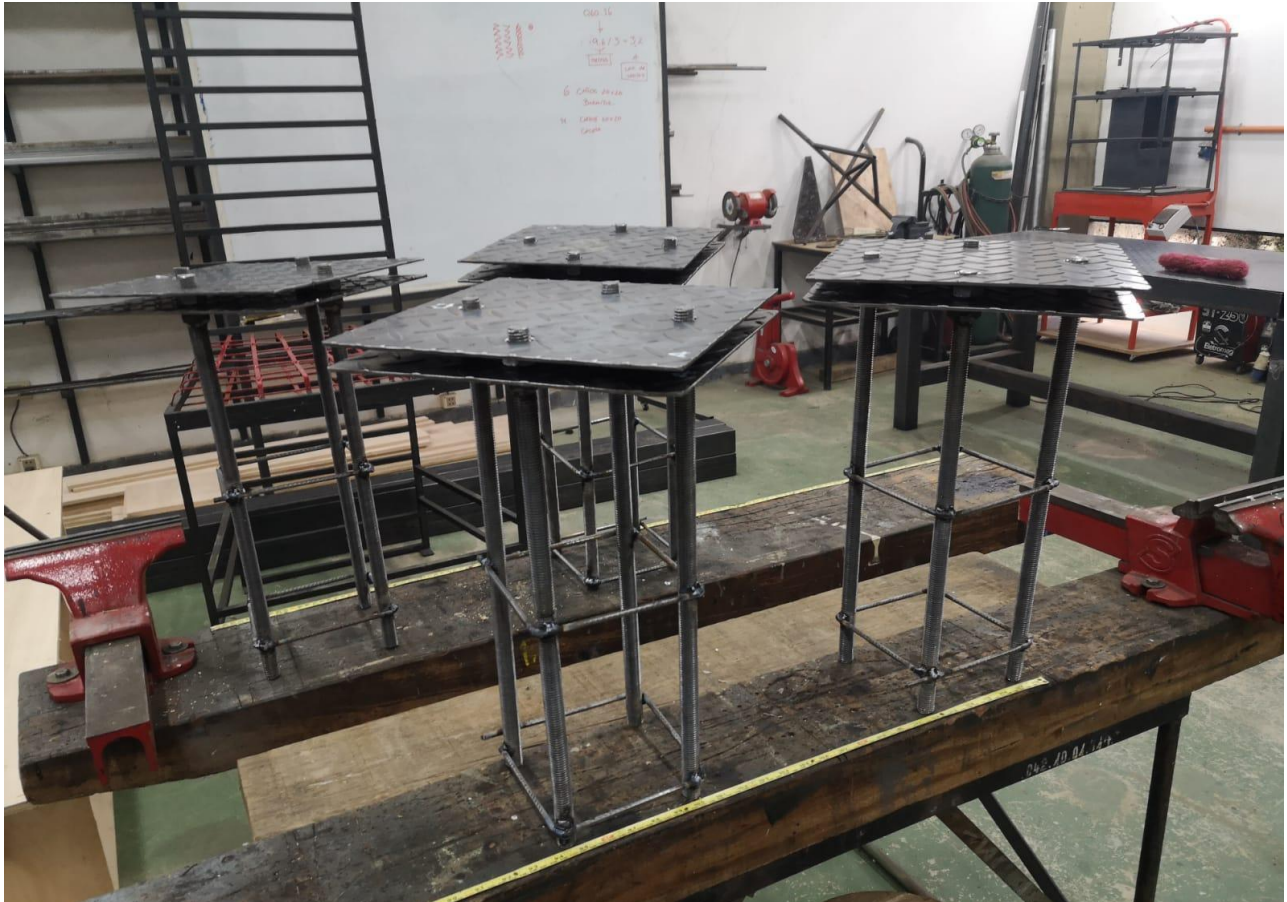
Fig. 64 Fabricación de estructuras metálicas
