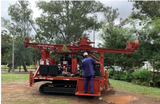
Fig. 158 Máquinas para el pozo artesiano
