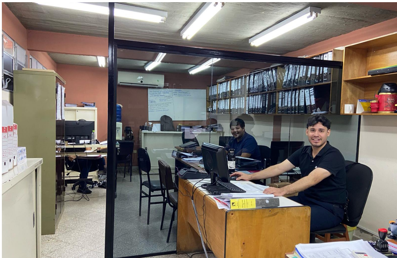
Fig. 169 - División con mamparas de vidrio templado – Oficina de UOC
