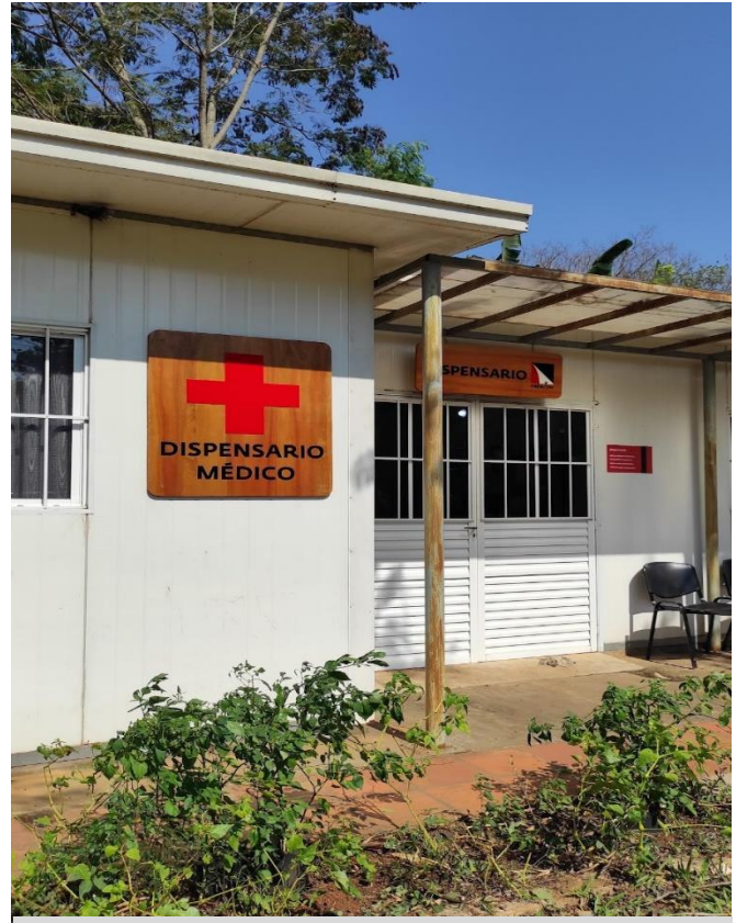
Fig. 71 Señalética y renovación de cartel para el dispensario de la FADA/UNA
